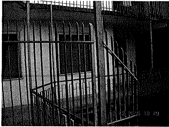
Foto 1 – Vista dal ballatoio di accesso
