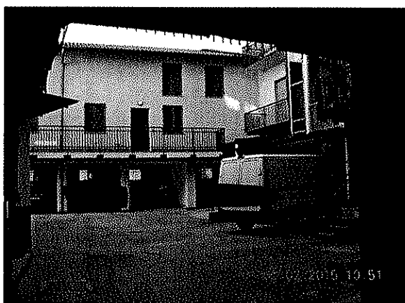
Foto 4 – Vista del cortile
